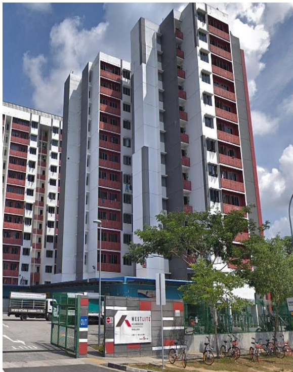
Foto 2 : Pembangunan CLQ Weslite Woodlands , Singapura
