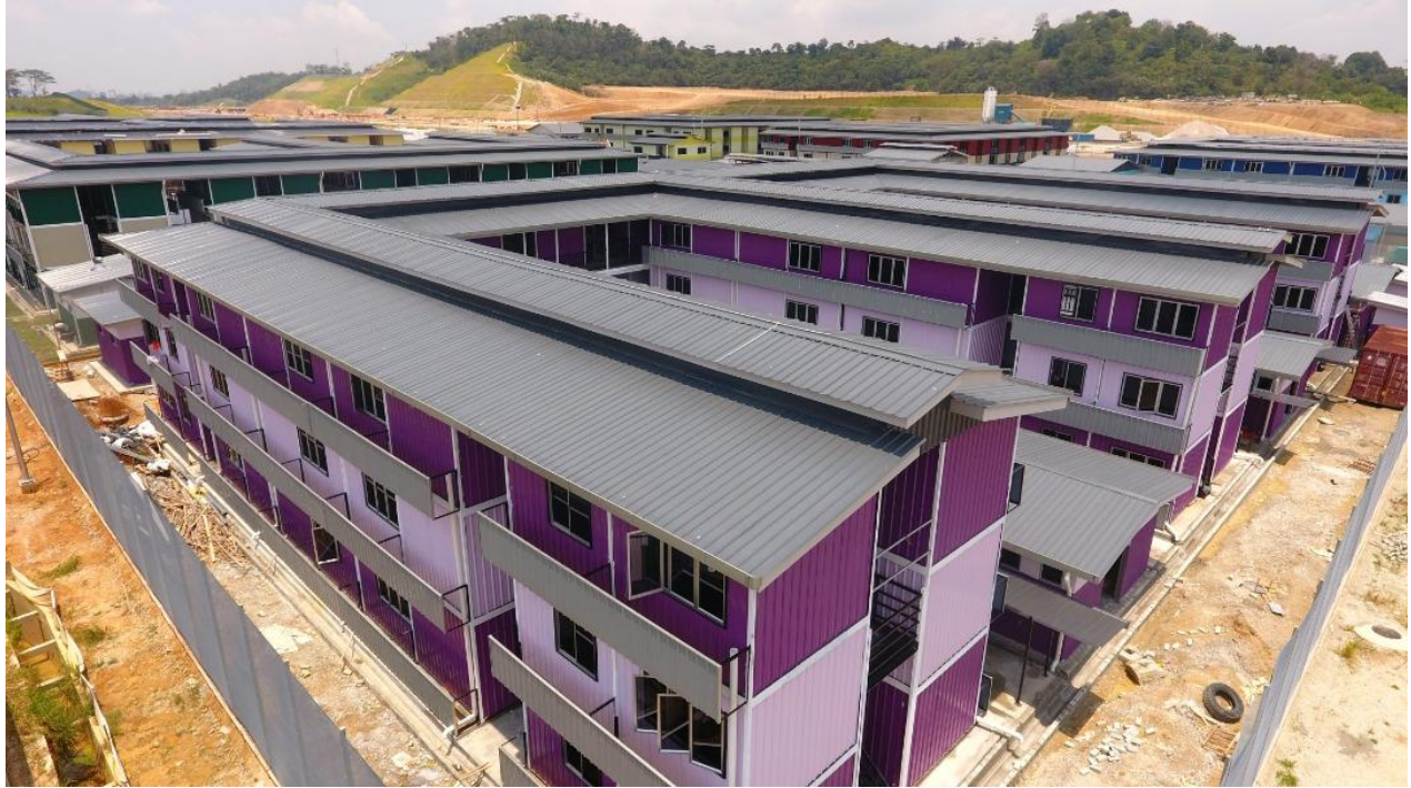
Foto 4 : Contoh Pembangunan CLQ MRT Sg. Buloh, Selangor
